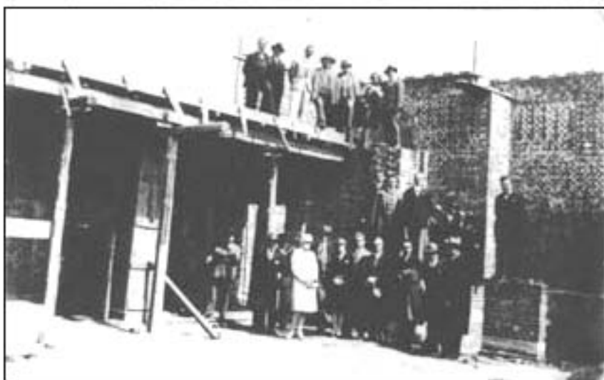
U listopada 1928. godine prije polaganja betonske skele, Hrvatski sokolski dom u izgradnji obilno je i zagrebački arhitekt Aleksandar Freundreich u pratnji Građevnog odbora
