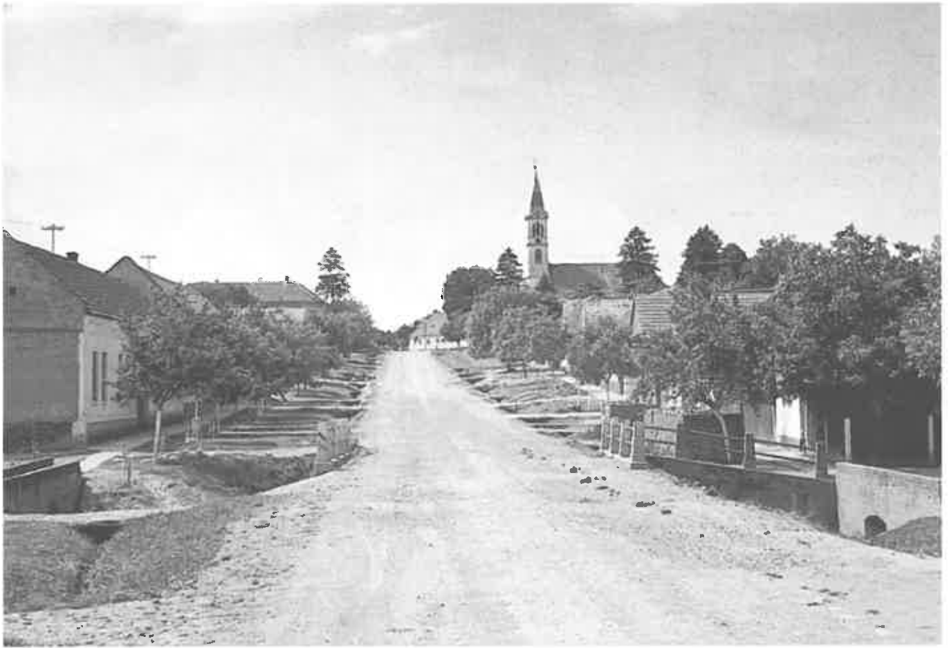
Gorjani – prije asfaltiranja ceste
