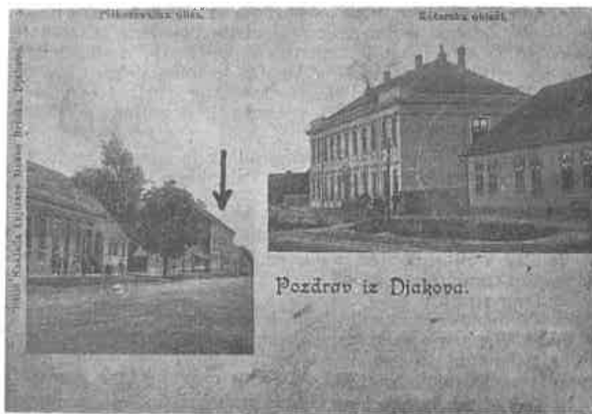
Sl. 2. Zgrada u kojoj se nalazila biskupijska tiskara
