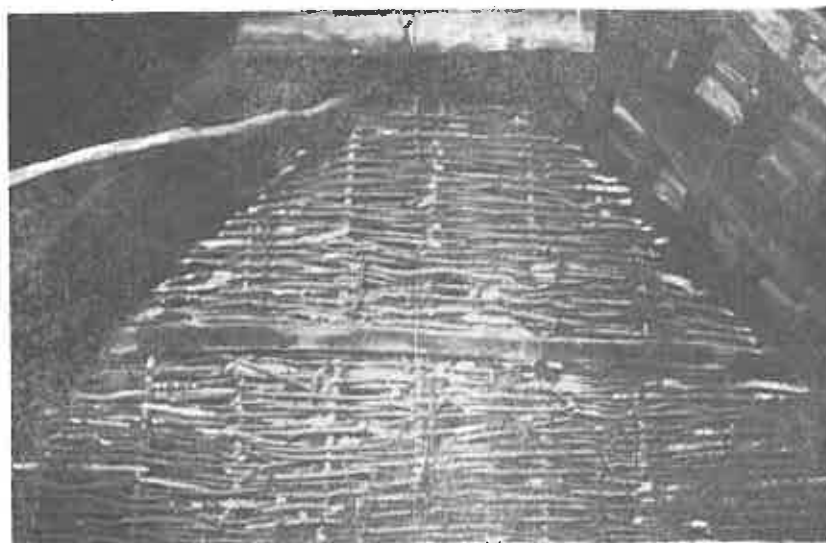
Sl. 20. Pletneri zabat na kući Pere Babića, Kondrić, kbr. 56 Snimljeno s tavanačke strane. Foto: Foto-grupa srednjoškolskog centra Đakovo
