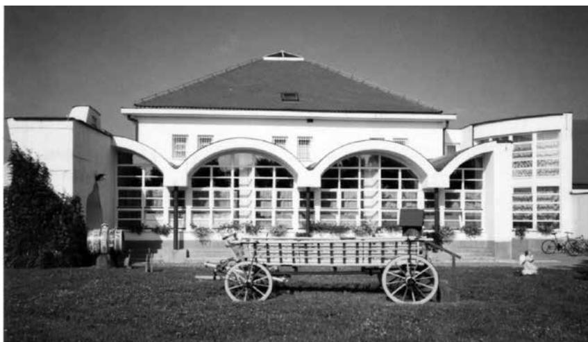
Zgrada novog vrtića
