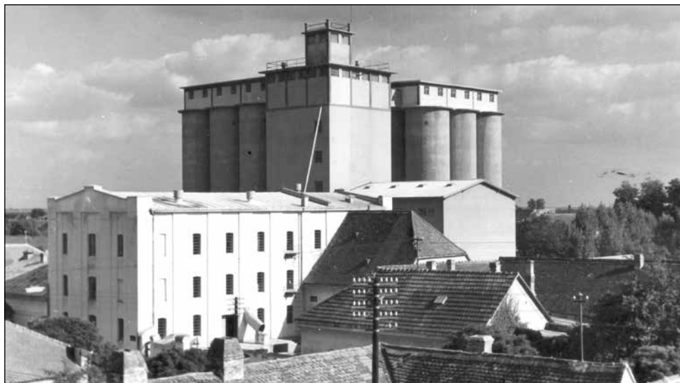
Stari vlastelinski mlin i kompleks novijih silosa. Snimljeno sedamdesetih godina 20. st.
